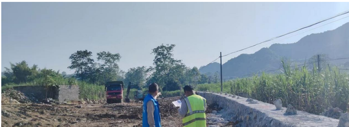
图五：巡线发现靠近有施工，提醒施工注意事项，避免破坏线路
